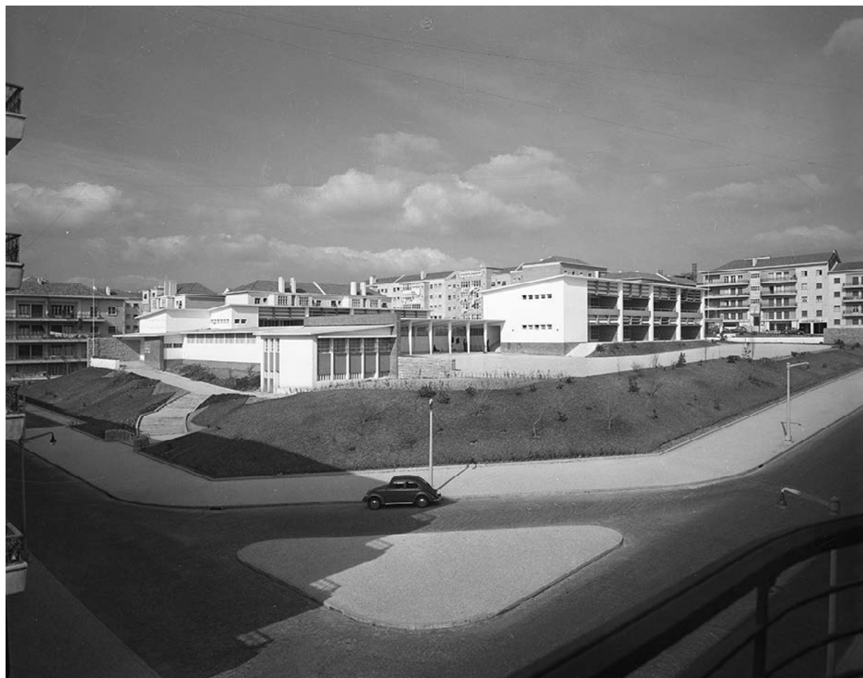
Figure 32 Escola Primária N.º 24, now Escola Básica do 1.º Ciclo do Bairro de São Miguel, located in Rua António Ferreira de Vasconcelos, photograph by Armando Maia Seródio, 1956. AML, PT/AMLSB/CMLSB/PCSP/004/SER/001139.
